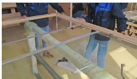
1. Previdno postavite stranski stekli na dvignjeno podlago in vstavite spodnji in zgornji del okvirja.
