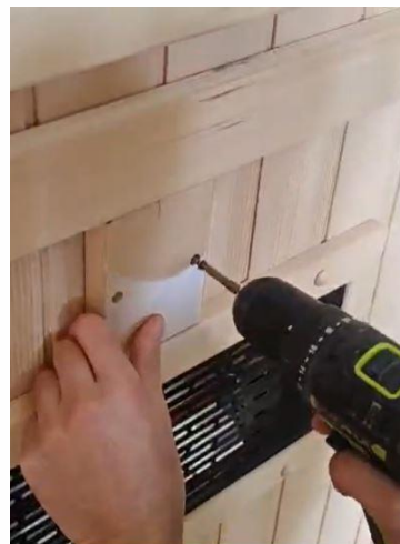
6. Spojite kable. Prekrijte luknje za povezavo grelcev z leseno ploščico in jo privijate.
